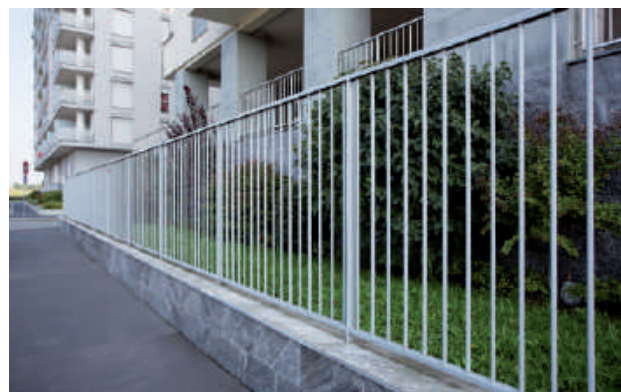
Dettaglio dei profili verticali tubolari con corrente orizzontale
