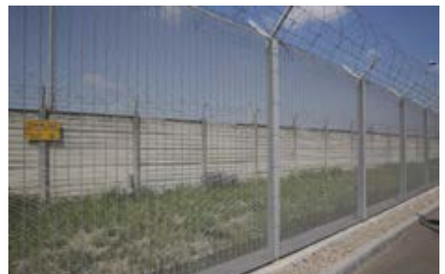
Palo Omega con piatto 60x40x25x3 o 120x60x30x3 mm
